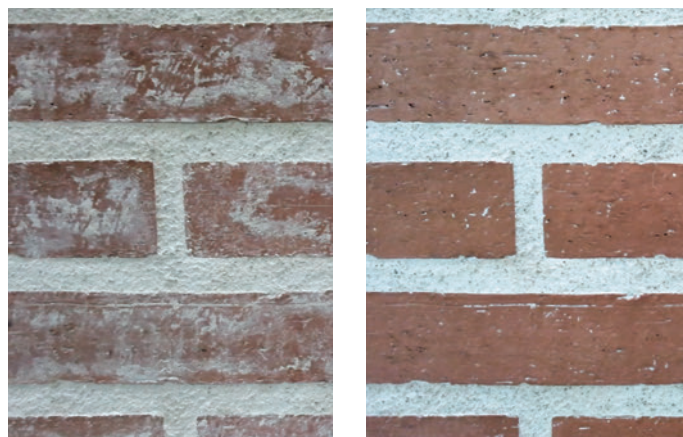
Limpieza de carbonatación en fábrica de ladrillo (antes y después)
