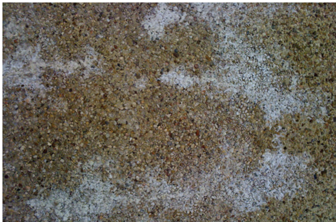
Limpieza de carbonatación de una superficie de mortero monocapa (antes y después)
