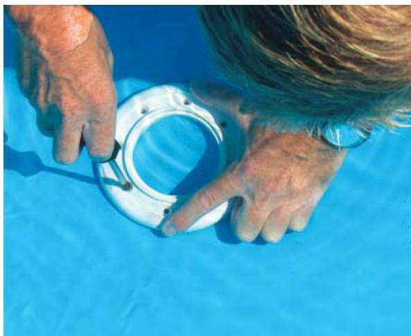
Pritrjevanje prirobnice talnega odtoka
