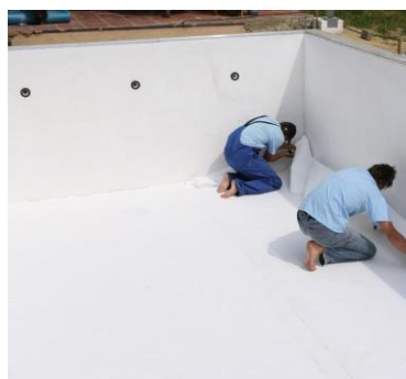
Filca na spojih ne prelagamo
