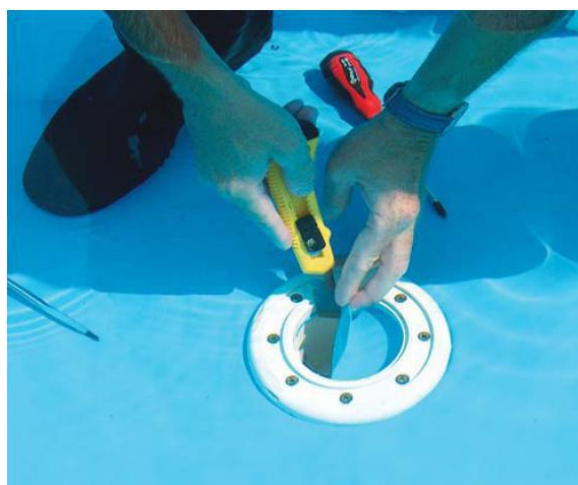
Izrezovanje folije po montaži prirobnice
