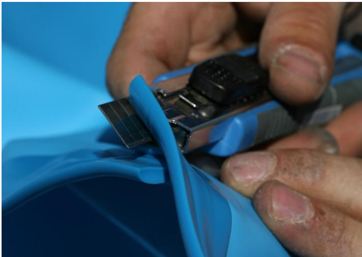
Rezanje odvečnega roba obesnega profila
