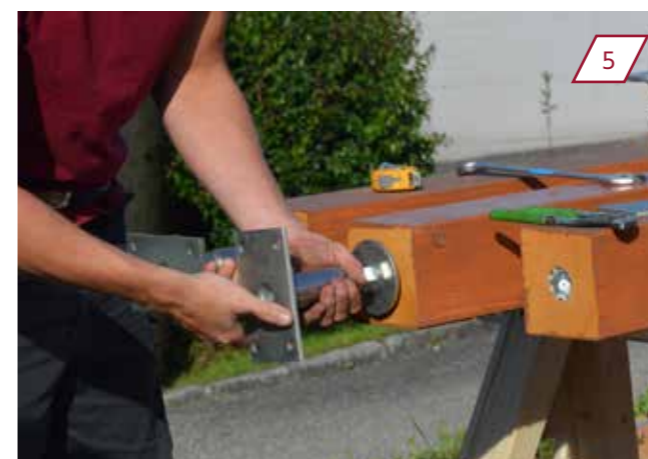
Die Stützfüße werden auf den Säulen angebracht.
