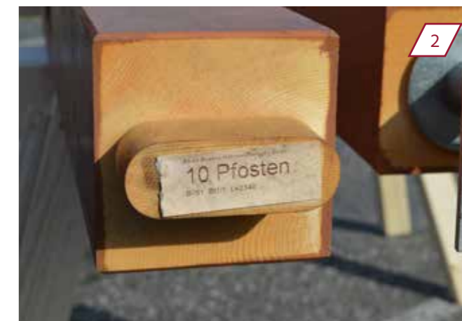
Die Balkennummern finden sich wiederum auf dem Etikett jedes Balkens. Damit können Verwechslungen ähnlicher Balken ausgeschlossen werden. Gleiches gilt für den Schraubenplan.
