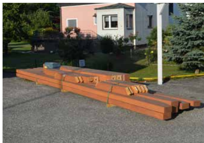
Gelieferte Holzbalken: Hier wurden die Balken vorab gestrichen.
