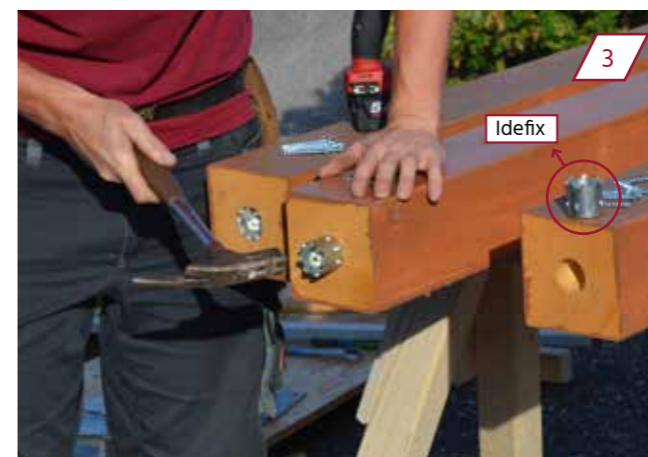
Die Steher mithilfe des Wandplans suchen. Die Idefixe der Stützfüße in die dafür vorgesehene Ausfräsung geben und mit einem Hammer in den Holzbalken hineinschlagen. Der Idefix soll bündig mit der Holzkante sein.
