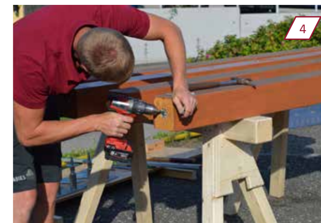
Die Idefixe festschrauben. Es ist zu beachten, dass die ersten beiden Schrauben bei der Befestigung diagonal gegenüber liegen sollen.
