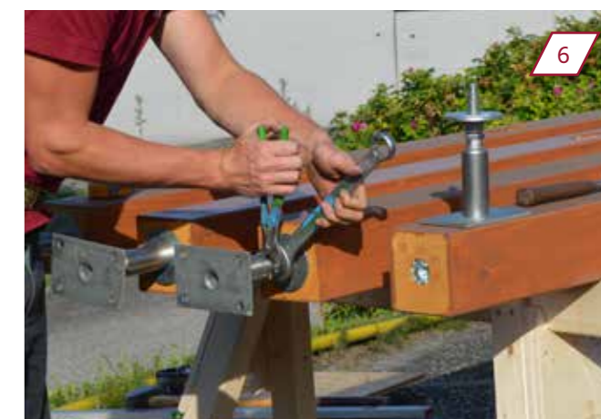
Mit Hilfe von Schraubenschlüssel und Rohrzange in entgegengesetzte Richtung festziehen.
