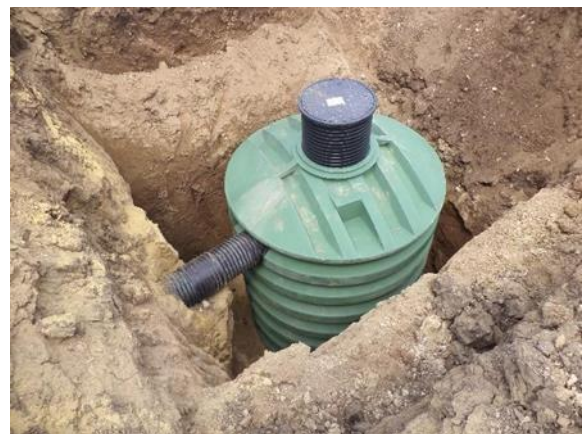
Bild 6 Eingebauter Behälter
