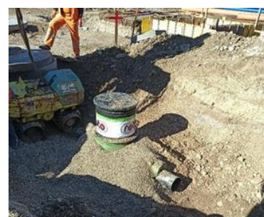
Bild 8: Verfüllen der Baugrube mit Kies 4 – 16 mm
