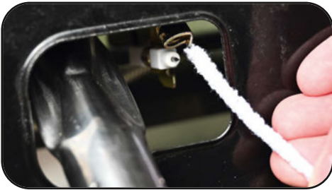
Pilot yakıcının bir lif teli veya bir pipo yardımı ile temizlenmesi.
