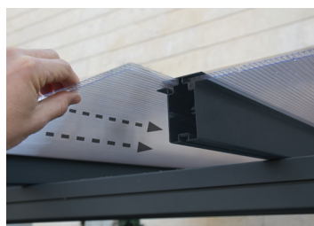
Sistem montaže drsnih plošč
