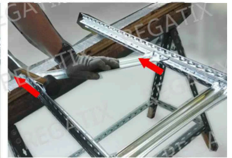
Dann die Diagonalen von der Vorderseite einklopfen., den Rahmen drehen....
