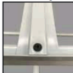
Befestigung des Querträgers und Verstärkung
