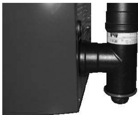
Fig. 29 - Reinigung des Rauchgaskanals
