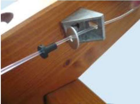
Den Polyesterdraht durch das Langloch des Drahthalters, dann durch die Unterlegscheibe und anschließend durch die Kunststofffülle ziehen. Die Richtung der Kunststofffülle ist zu beachten
