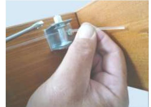
Das andere Ende vom Polyesterdraht durch das Loch im Drahtspanner ziehen und ca. 10 cm überstehen lassen. Mit der Hand den Polyesterdraht ganz leicht vorspannen, damit die Kunststofffülle nicht aus der Unterlegscheibe ablässt
