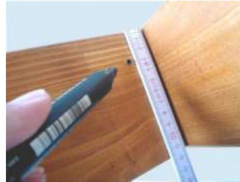
Montagepunkt für den Drahtspanner min. 3 cm von Oberkante des Sparren anzeichnen
