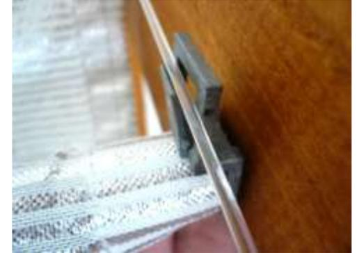
Federclip anschließend von unten auf den Polyesterdraht klippsen
