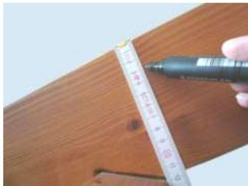
Montagepunkt für den Drahthalter min. 3 cm von der Oberkante Sparren anzeichnen. Setzen sie aber den Montagepunkt auf die gleiche Höhe wie bei dem Drahtspanner
