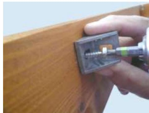
anschrauben des Drahthalters. Nachdem die Bohrspitze das Aluminium durchdrungen hat, greift das Schraubengewinde.
