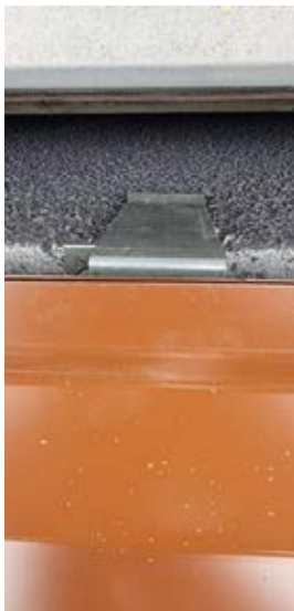
Attikahaken seitlich von oben runter betrachtet
