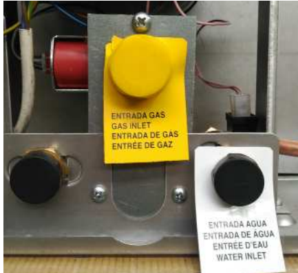
fig. 10 - Tarjetas de conexiones
