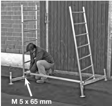
Basissteiger met eerste slag
