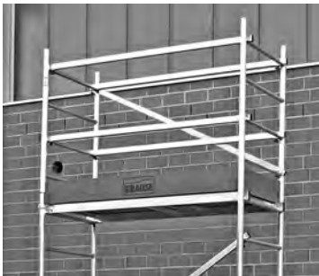
Basissteiger met eerste slag
