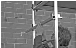
Basissteiger met eerste slag
