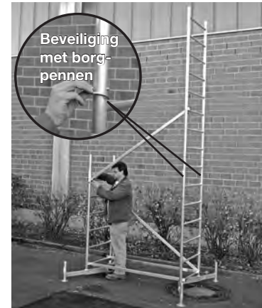
Basissteiger met eerste slag
