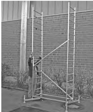
Basissteiger met eerste slag
