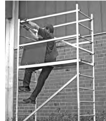
Basissteiger met eerste slag
