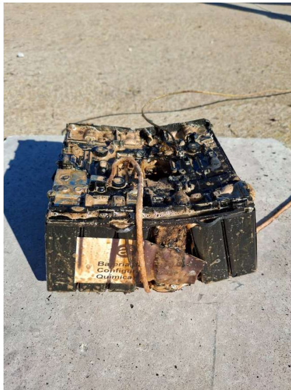
Figura 23: Estado de la batería después del ensayo 1.
