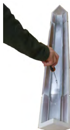
Fig. 26 - Das Profil an den Majoliken anschrauben
