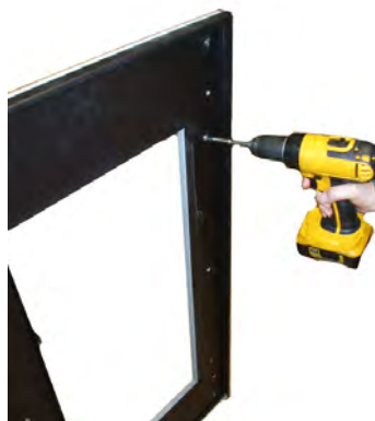
Fig. 34 - Die Steinelemente befestigen
