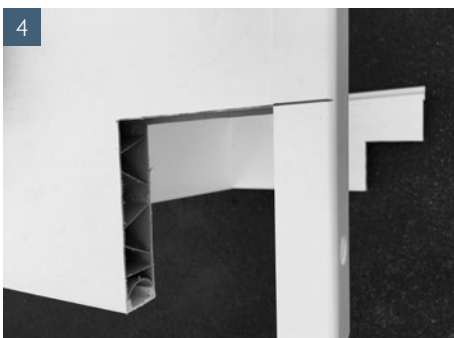
Wandanschlussprofil aufschieben und zuschneiden
