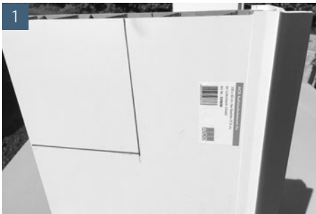
Wandanschlussprofile entfernen und Ausklinkung anzeichnen
