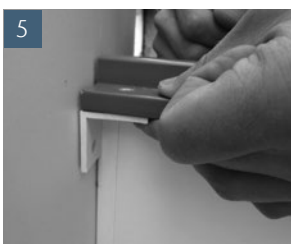
Kunststoffwinkel anhalten. Große Bohrung zeigt nach oben
