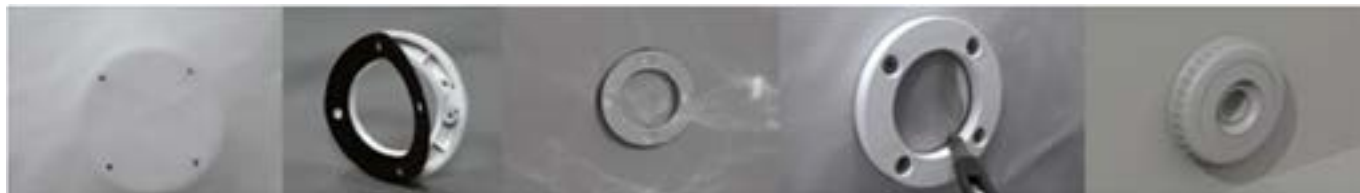
Abbildung 28 – Montage des Flansches an der Wanddurchführung der Einlaufdüse
