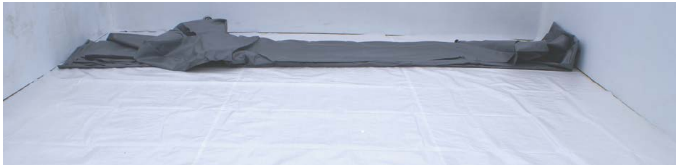
Abbildung 26 – Entfalten der Folienauskleidung
