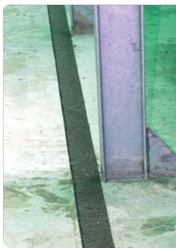
Abbildung 7 – Schaffung der Bitumenstreifen
