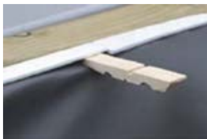
Abbildung 27 – Verklebung der Folienauskleidung mithilfe der halben Wäscheklammern
