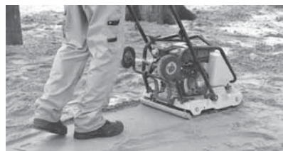
Verdichten van de bodem
