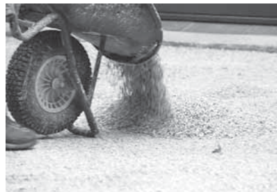
Aanbrengen van de vul en deklaag
