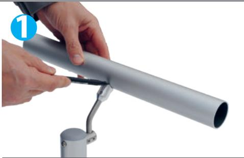
Handlauf an bereits vormontiertem Handlaufhalter positionieren und anzeichnen.
