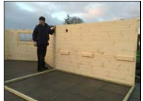
Wände auf Unterkonstruktion
