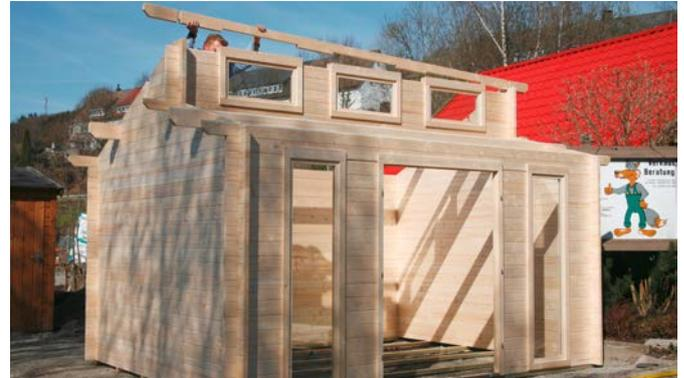
Bei der Dachschalung fangen Sie an der Innenseite der Giebelwand an. **Achtung:** Bei der kleineren Dachfläche (über der Tür-Fensterfront) verwenden Sie die Profile mit der Länge **144,5 cm**. 6 Dachbretter haben die Länge **148,5 cm**. Diese werden ganz links und rechts aussen am Dachüberstand eingesetzt. Arbeiten Sie sich als erstes mit den längeren Brettern am Dachbalken nach aussen. Hierbei müssen zwei Ausklinkungen vorgenommen werden.
