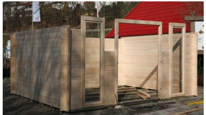
Vor der Montage muß der Stockrahmen der Tür zusammengesetzt werden. Legen Sie die entsprechenden Teile auf einem ebenen Untergrund aus, stecken Sie ihn zusammen und verschrauben Sie die Eckverbindungen. Ein Unterlegen von Holzresten vermeidet Verschmutzungen und Schrammen im Holz.
