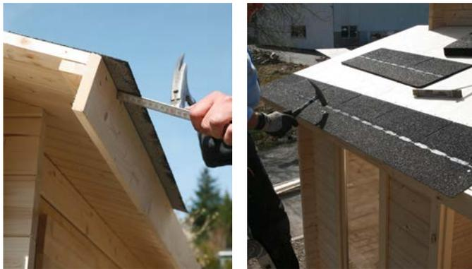
So arbeiten Sie sich Bahn für Bahn nach oben. **Wichtig** ist, dass Sie zum Schluss einen möglichst dichten Fugenanschluss an die Dachfensterfront erreichen. Die Dachfenster können kurz nach oben geschoben werden, um die Schindeln unter den Fensterrahmen zu schieben. Die Fuge zwischen Fensterfront und Schindeln sollte mit **Bitumenkaltkleber** abgespritzt werden. Abschließend mit der Hakenmesser Klinge die seitlichen Überstände versäubern.
