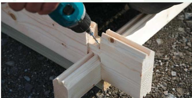
An mehreren Stellen können die Bohlen mit den Bodenbalken verschraubt werden. Auch im Durchgangsbereich sollte vor Kopf eine Schraube sitzen. Die Vorder- und Rückwand liegt nicht vollflächig auf den Balken auf, sondern ragt ca. 3-4mm über die Bodenbalken hinaus. So kann das Wasser abtropfen.
