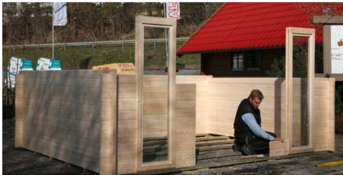
Der komplette Türrahmen kann nun von oben auf die Wände geschoben werden. Eine weitere Verbindung zwischen Türen und Fenstern mit den Wänden ist nicht erforderlich. So kann das Holz später ungehindert arbeiten.
