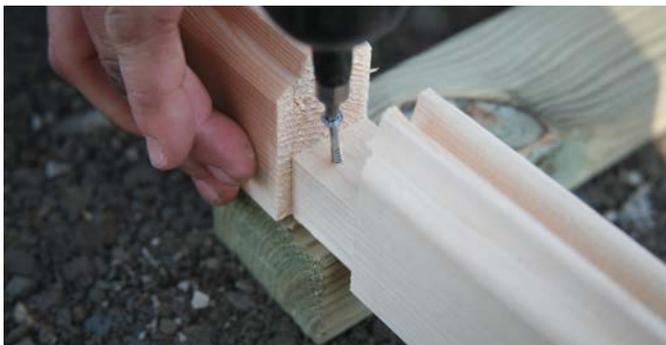
Nun werden die beiden kurzen Frontbohlen links und rechts und die erste Rückwandbohle in die Eckverbindung eingelegt. Auch hier wird eine Verschraubung in den Ecken vorgenommen.
