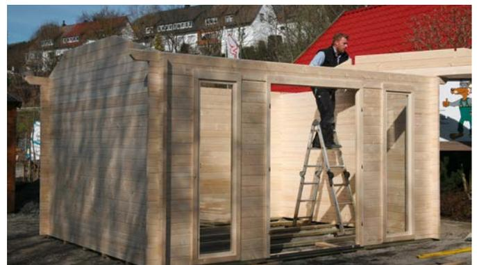
Die ersten Dachbalken, erkennbar an der angefrästen Dachschräge werden vorn und hinten auf die Wände gesetzt.
