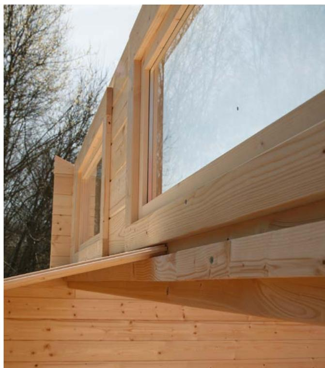
Nun wird das Dach vollflächig vernagelt, bzw. verschraubt. Achten Sie hierbei auf einen geraden Verlauf an den äusseren Dachkanten, damit Sie im nächsten Schritt die Leisten sauber anbringen können.
