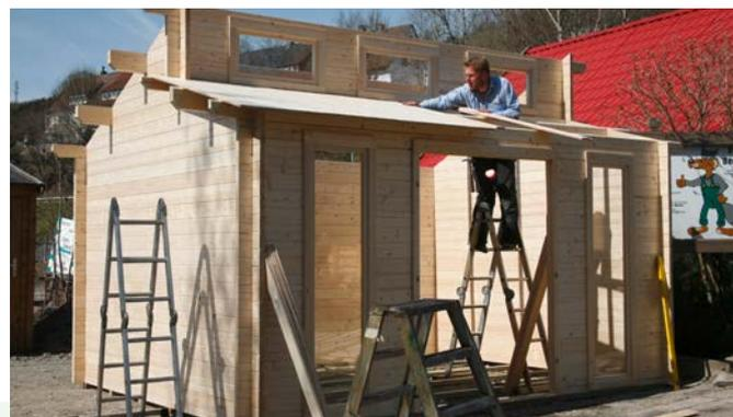
Nach Fertigstellung der Dachflächen werden an allen Dachkanten die breiten Traufenbretter und die schmalen Traufenleisten angeschraubt.
