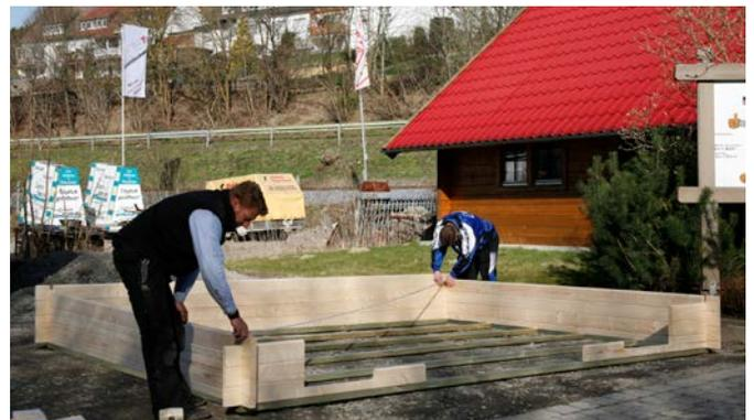
Erst wenn die Bauhöhe des Hauses etwa **50-60 cm** erreicht hat, ist durch das höhere Eigengewicht ein **Ausrichten sinnvoll**. Prüfen Sie mit der Wasserwaage umlaufend die Wände auf Waagerechtigkeit. Durch Unterklotzen mit Steinplatten und Hartholzresten wird der ganze Bau in Waage gestellt.
