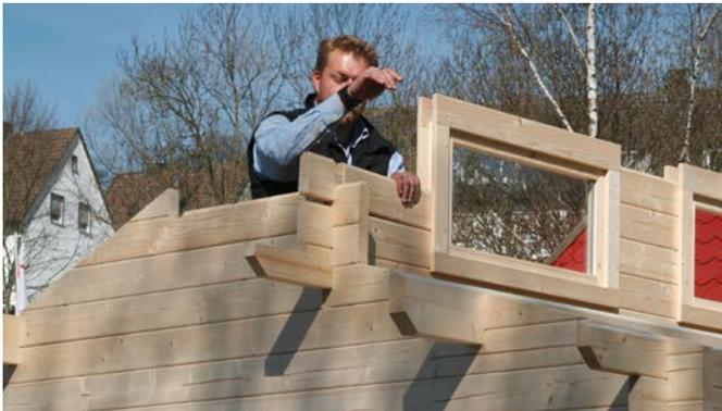
Jetzt wird mit den dafür vorgesehen Einzelteilen der Giebel ergänzt und der letzte Dachbalken auf den Giebel gesetzt.
