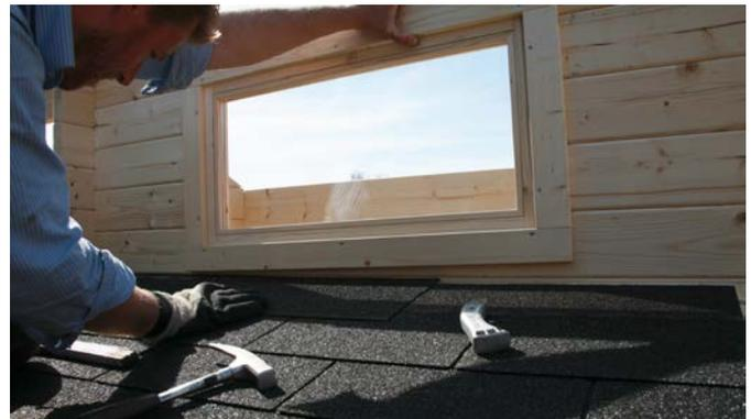
Die folgenden Reihen werden überlappend aufgelegt. **Achtung:** Auf einer Bahnlänge sollten etwa 4 Dachpappstifte verwendet werden. Diese immer oberhalb des glänzenden Klebestreifens setzen. So werden die Nagelköpfe immer von der nächsten Schindel verdeckt.
