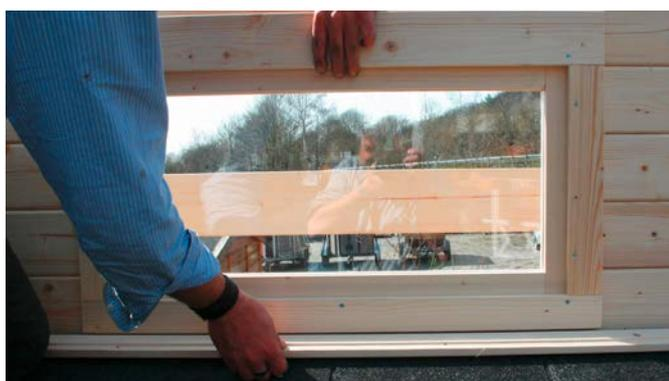
Nun wird die ganze Blende an den Kopfenden der Dachbalken befestigt.
