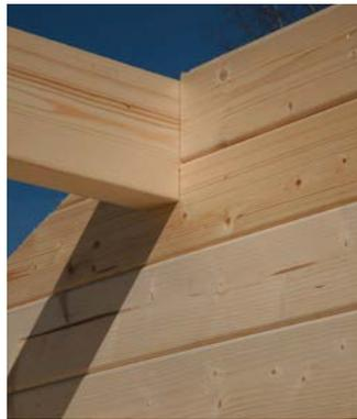
Der nächste wichtige Montageschritt ist das Montieren des dünnen Dachbalkens unter der späteren Dachfensterfront, erkennbar an der besonderen Endausfräsung.
