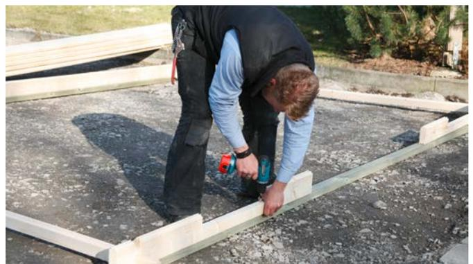
Nun werden die restlichen Bodenbalken für den späteren Fußboden gleichmäßig im Innenraum verteilt, und auf die gleiche Weise mit den Wandbohlen verbunden.
