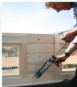
... festschrauben und abschließend auch hier mit Bitumenkaltkleber aus der Tube abdichten.
