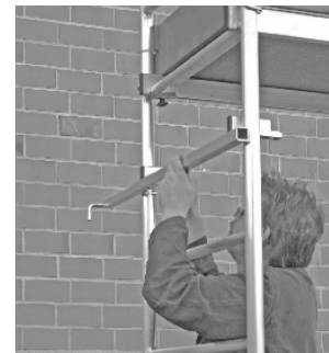
Grundgerüst mit erster und zweiter Aufstockung
