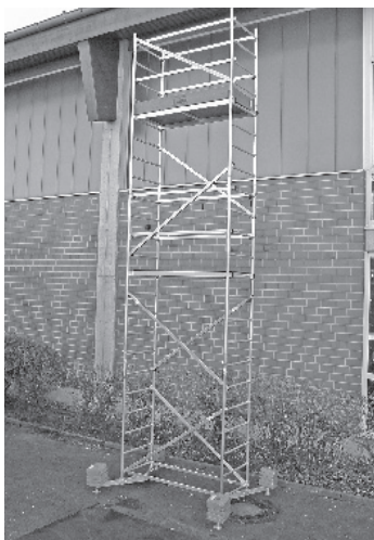
Grundgerüst mit erster und zweiter Aufstockung
