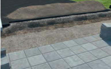
1. Graben für das Betonbett ausheben. Das Betonbett soll später ein Mindestmaß von 5 cm Höhe und 20 cm Breite haben. Wir empfehlen die vordere und die hintere Reihe der Pflastersteine auch mit in ein Betonbett zu setzen. (siehe Seite 25)
