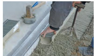
9. Seitliche Betonstütze gemäß Einbauempfehlung herstellen
