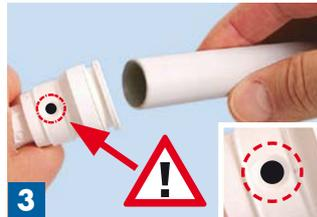
Zusammenstecken – führen Sie nur ein **korrekt angefastes Rohr** bis zum Anschlag in den Fitting ein!
