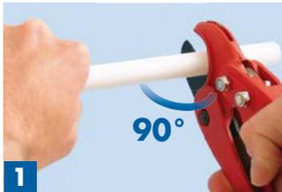
Ablängen – längen Sie das Rohr im rechten Winkel (90°) ab. **Wichtig:** Marley Kunststoffrohr-Schere verwenden, **keine Säge!**
