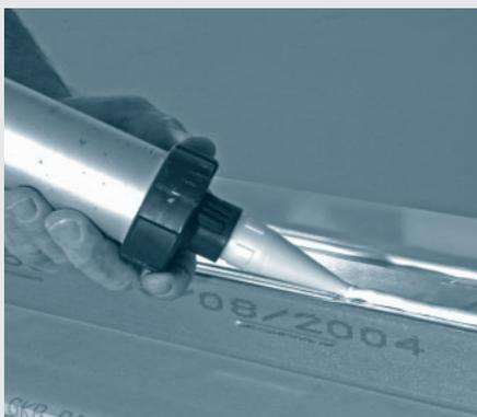
2. Auftragen von Knauf Trennwandkitt zur Abdichtung des Anschlusses
