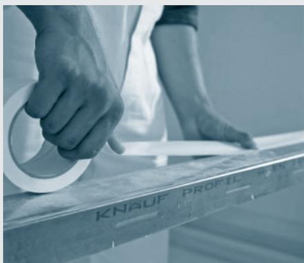
1. Aufdrücken des selbstklebenden Knauf Trenn-Fix auf das CW-/UW-Profil
