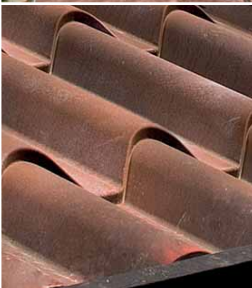
Dettaglio della copertura
