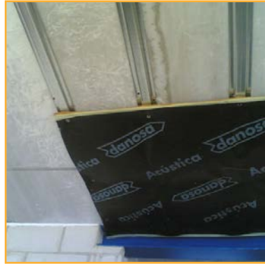
Sistema tornillo-arándela sobre maestra.
