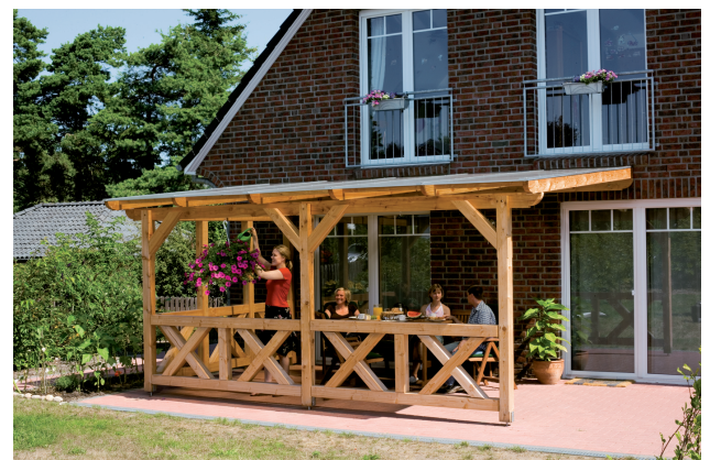
Kundenfoto: Terrassenüberdachung mit Brüstungen und Seitenwand
