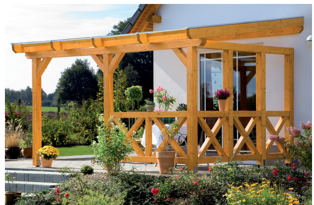
Kundenfoto: Terrassenüberdachung mit einer Brüstung und Seitenwand
