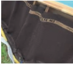
Felt • Filtro Feutrine • Filz Feltro • Vilt Alveolar protection in HDPE Protección alveolar en PEAD Protection alvéolaire en PEHD Alveolar Schutz in PEHD Protezione alveolare in PEAD Beschermdende HDPE-noppenfoli Proteção alveolar em PEAD
