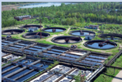
Reinigung von Abwässern
