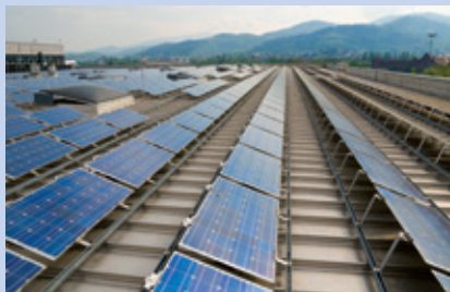
Trägergas bei der Solarzellen Produktion
