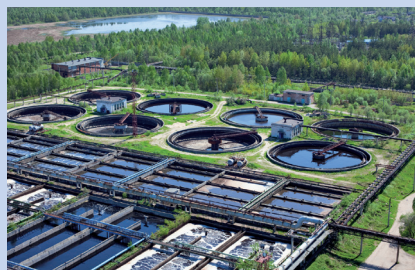
Neutralisation alkalischer Abwässer
