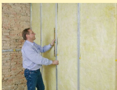
5. Colocar la Lana Mineral ISOVER: ECO D 032.
