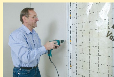
7. Fijación de la Placa de Yeso Laminado.
