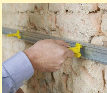
3. Colocar los Clips OPTIMA 2 .
