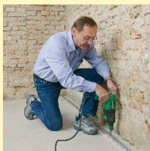
2. Fijación de los perfiles OPTIMA U ST.
