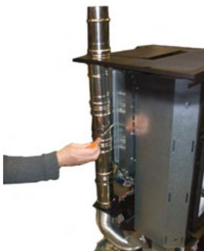
Fig. 40 - Positionierung der Rohre für oberen Kanal
