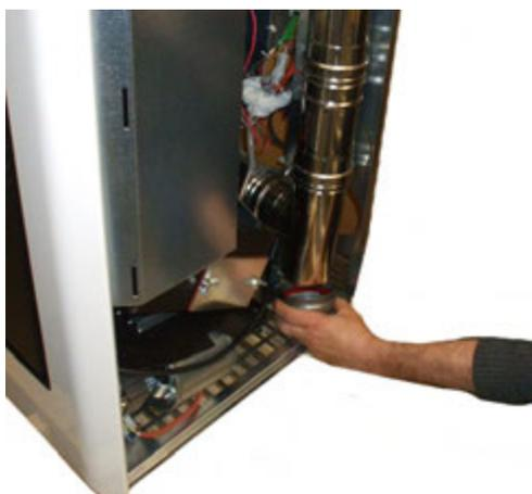
Fig. 74 - Reinigung des Rauchgaskanals
