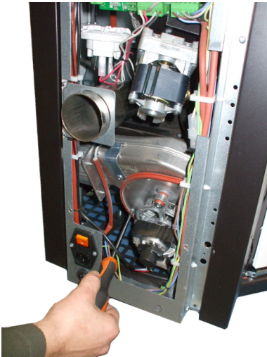
Fig. 76 - Reinigung Rauchgasansauggerät: Phase 1
