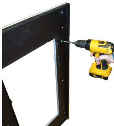
Fig. 33 - Die Steinelemente befestigen
