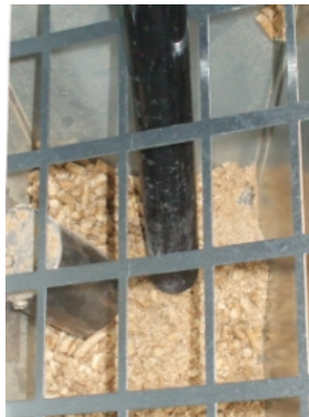
Fig. 55 - Reinigung Tank und Schnecke
