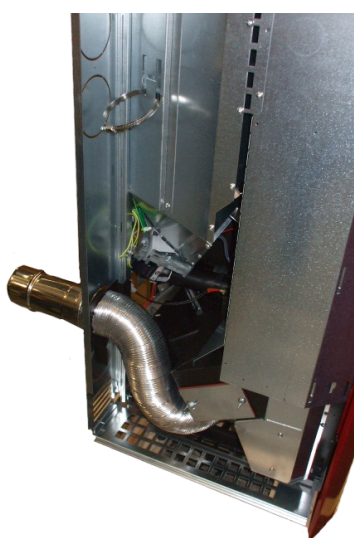
Fig. 42 - Positionierung der Rohre für hinteren Kanal
