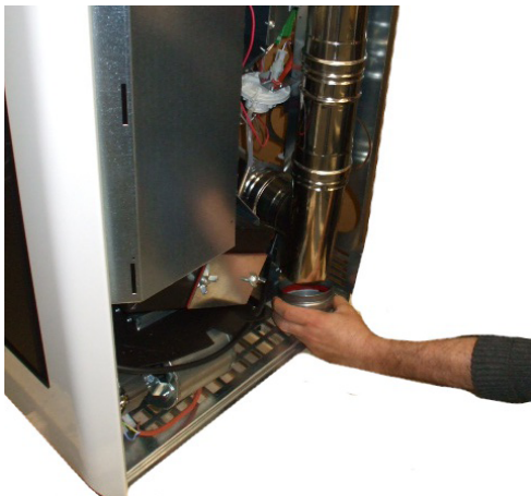
Fig. 74 - Reinigung des Rauchgaskanals
