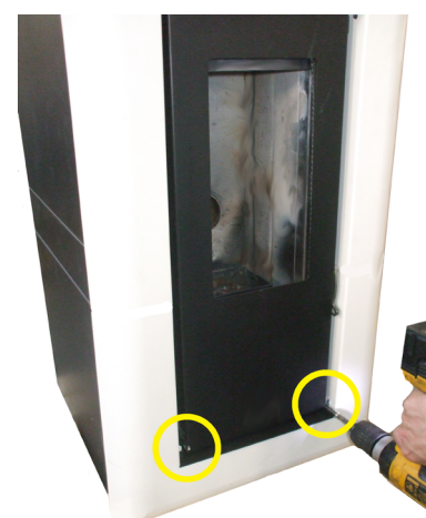
Fig. 23 - Befestigung Rahmen
