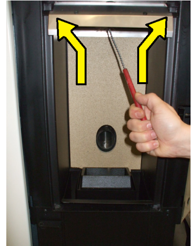
Fig. 70 - Beide Rohre reinigen
