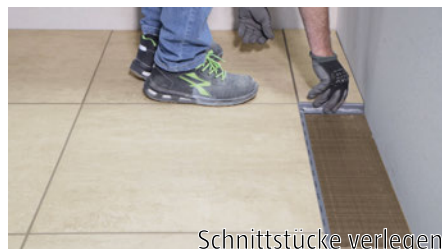
Platten Stück für Stück verlegen.
