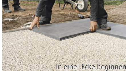
Splittbett erstellen, bspw mit 2/5er Splitt
