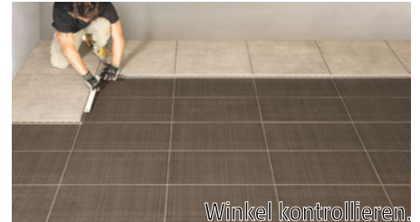
Platten Stück für Stück verlegen.
