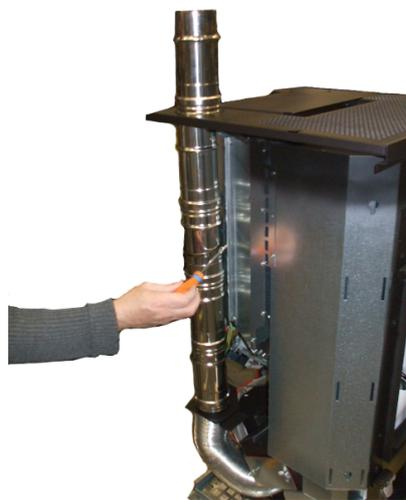
Fig. 40 - Posicionamiento superior de los tubos
