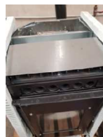
QUITAR TORNILLOS Y LIMPIAR REGISTRO PASO DE HUMO
